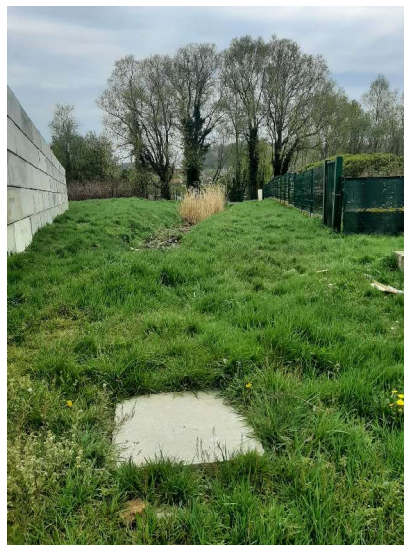
Figure 6. Zone d'infiltration de eaux pluviale
